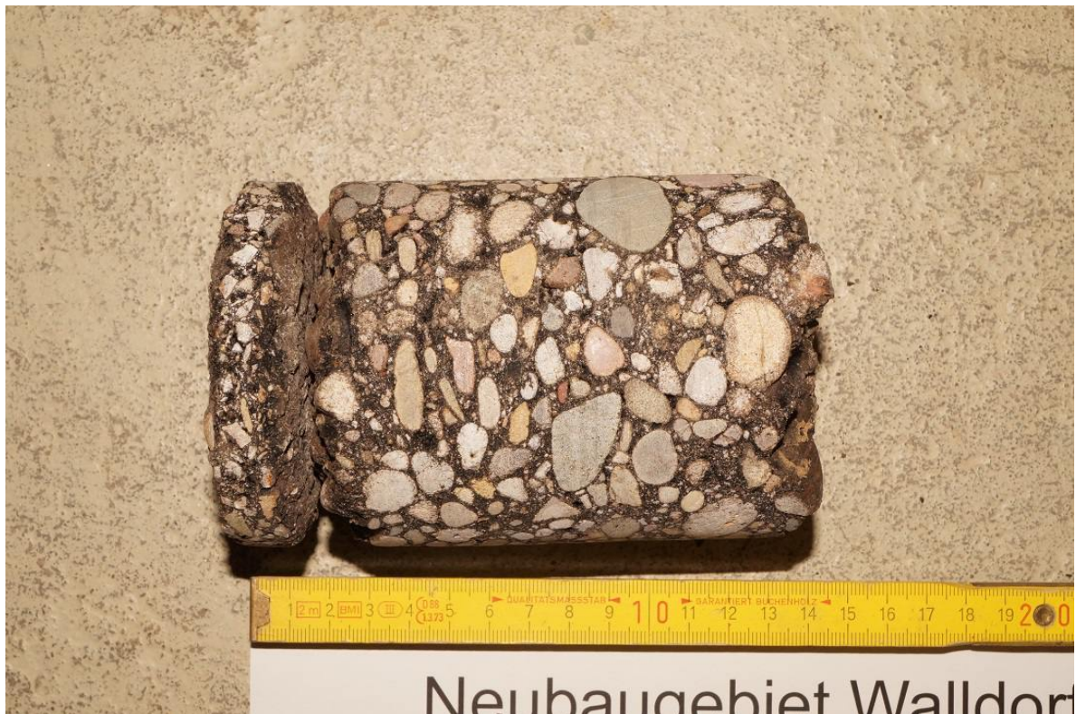
Bild 10: Detailaufnahme Asphaltkern KB 4
