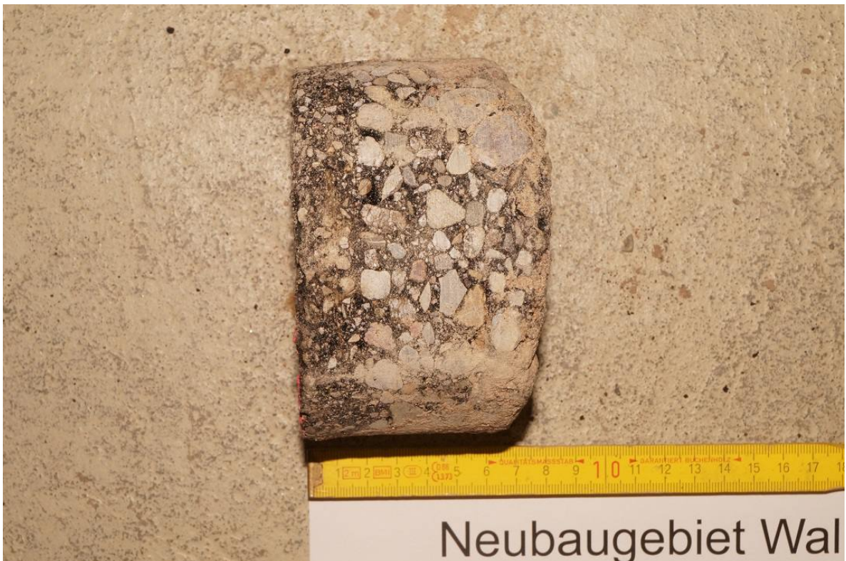
Bild 20: Detailaufnahme Asphaltkern KB 9
