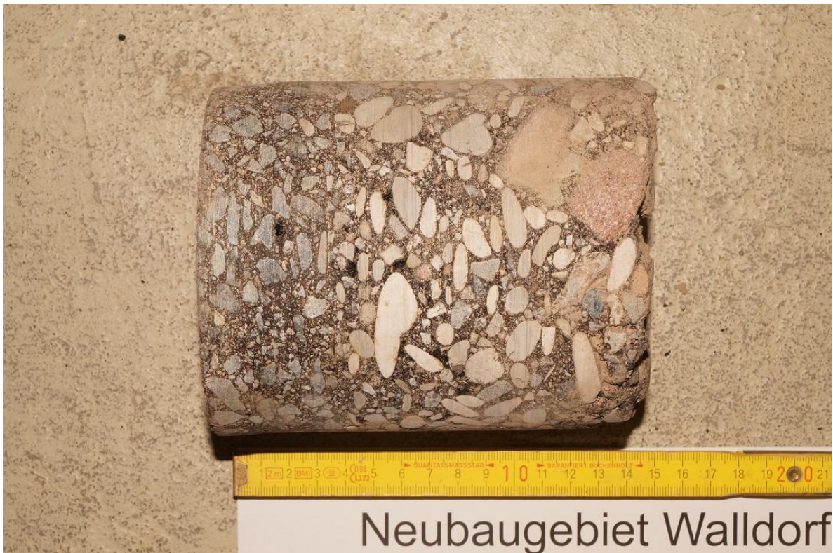
Bild 18: Detailaufnahme Asphaltkern KB 8
