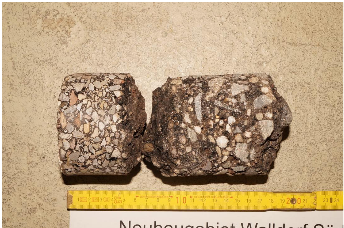
Bild 6: Detailaufnahme Asphaltkern KB 1
