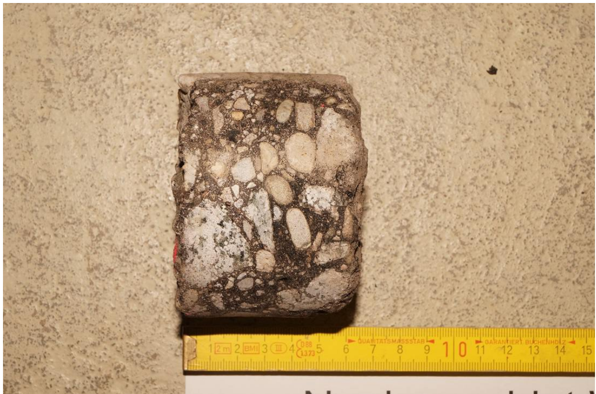
Bild 4: Detailaufnahme Asphaltkern KRB 30
