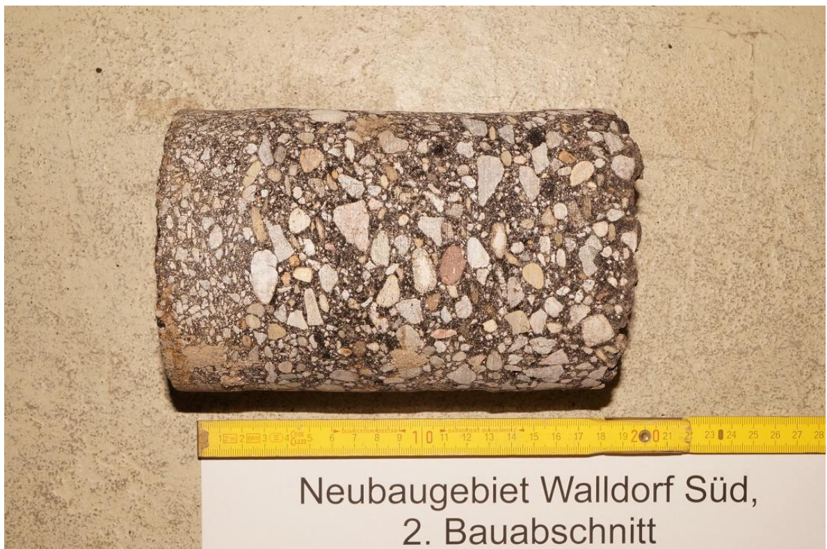
Bild 16: Detailaufnahme Asphaltkern KB 7
