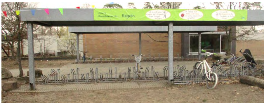
Abbildung 76: Überdachte Fahrradabstellanlage mit Felgenklemmern an der Walldorfschule (eigenes Foto (VAR+, 2021))
