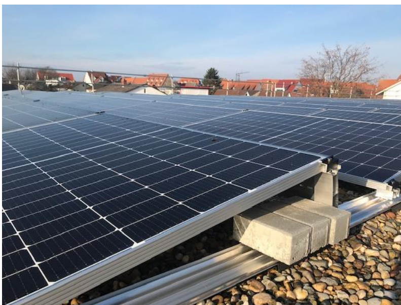
Im Bau befindliche PV-Anlage Schillerschule Sporthalle Dezember 2020
