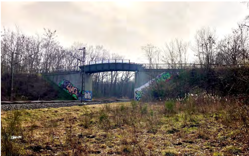
Abb. 30: Radweg Alte Roter Straße - Querung der Bahngleise
