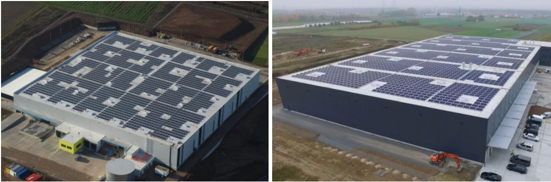
Abb. 3: Beispiele für großflächige PV-Anlagen auf Logistikhallen (Foto links: EnBW, Foto rechts: BayWa r.e. renewable energy GmbH)
