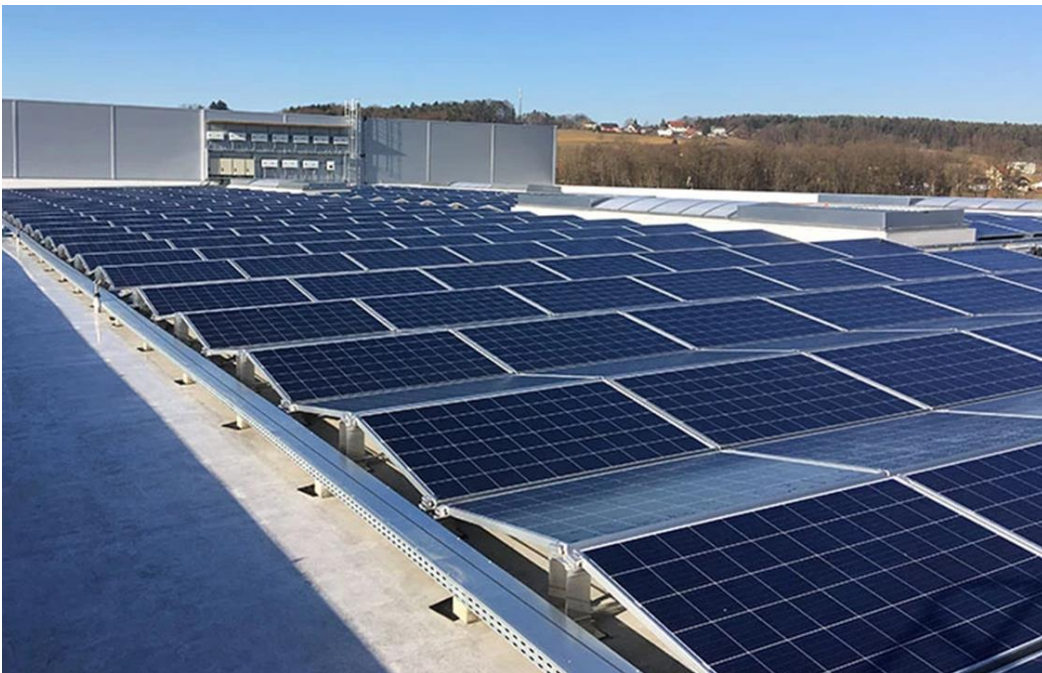
Abb. 4: Beispiel für eine PV-Anlage mit flach geneigten Modulen in Ost-West-Orientierung (Foto: SOLAREL GmbH, Paldau)
