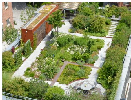
Beispiel für eine intensive Dachbegrünung
