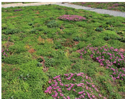
Beispiel für eine extensive Dachbegrünung
