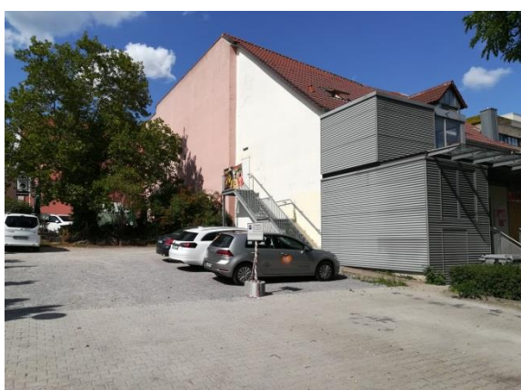
Foto 23: Obere Grabenstraße - untergenutzter Bereich
